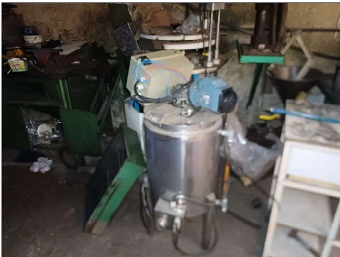
ITEM 068 - CALDEIRA A VAPOR INDUSTRIAL
