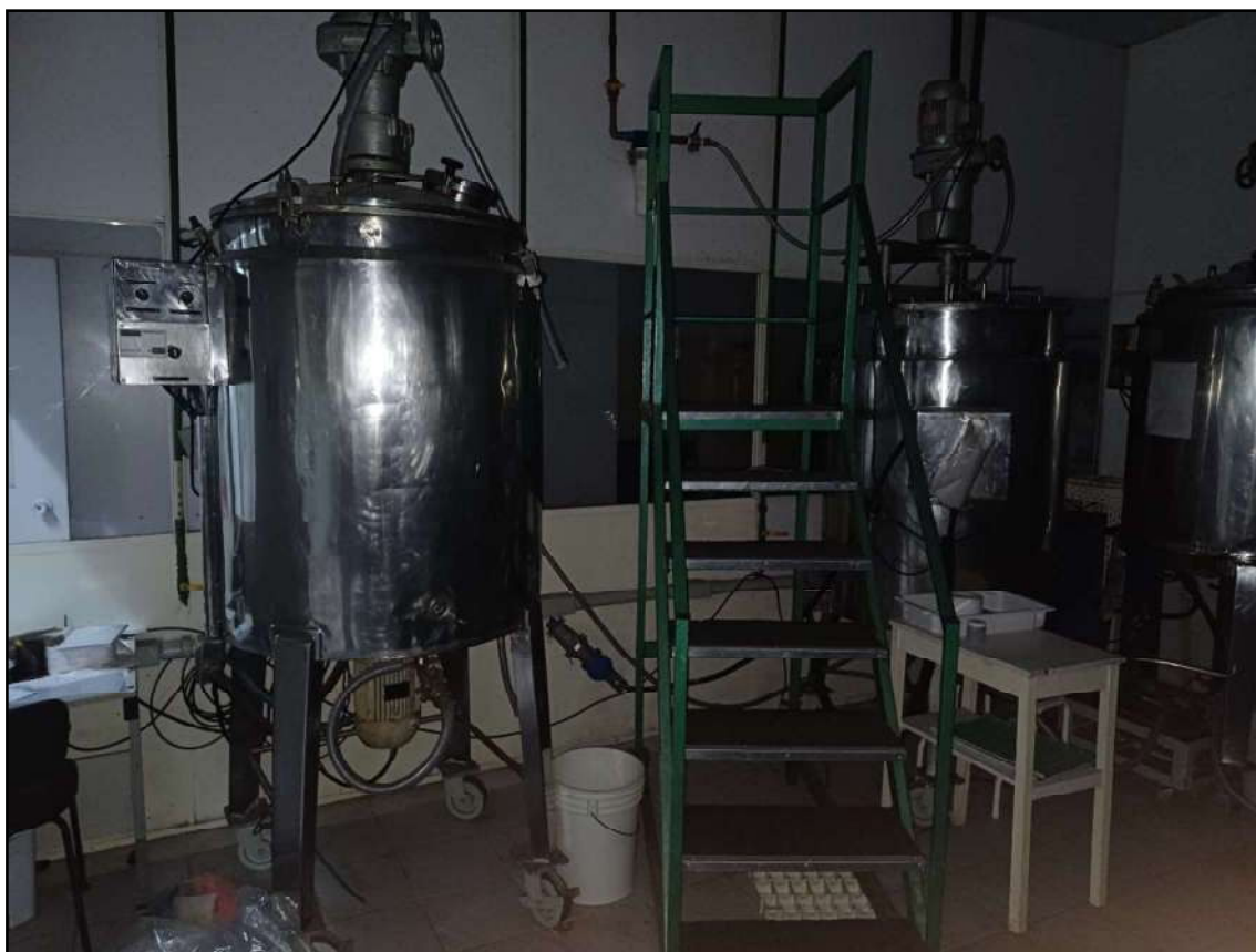
ITEM 054 - ESCADA METAL INDUSTRIAL
