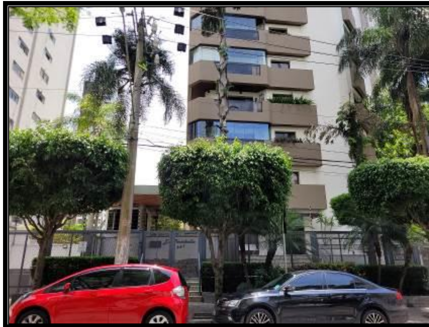
Vista da frente do Edifício Portobello.
