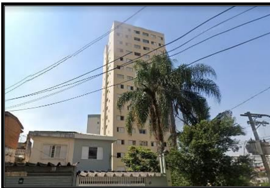
Vista do Edifício Cláudia.
