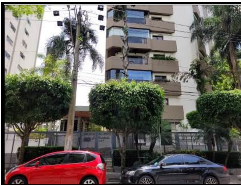
Vista da frente do Edifício Portobello.
