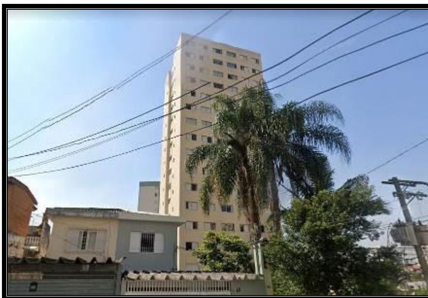
Vista do Edifício Cláudia.
