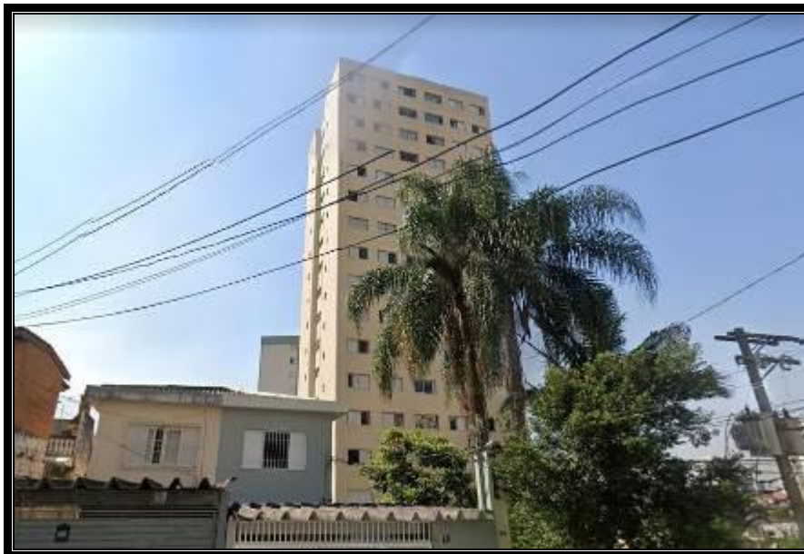
Vista do Edifício Cláudia.
