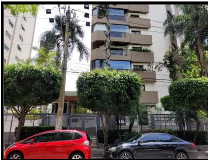
Vista da frente do Edifício Portobello.
